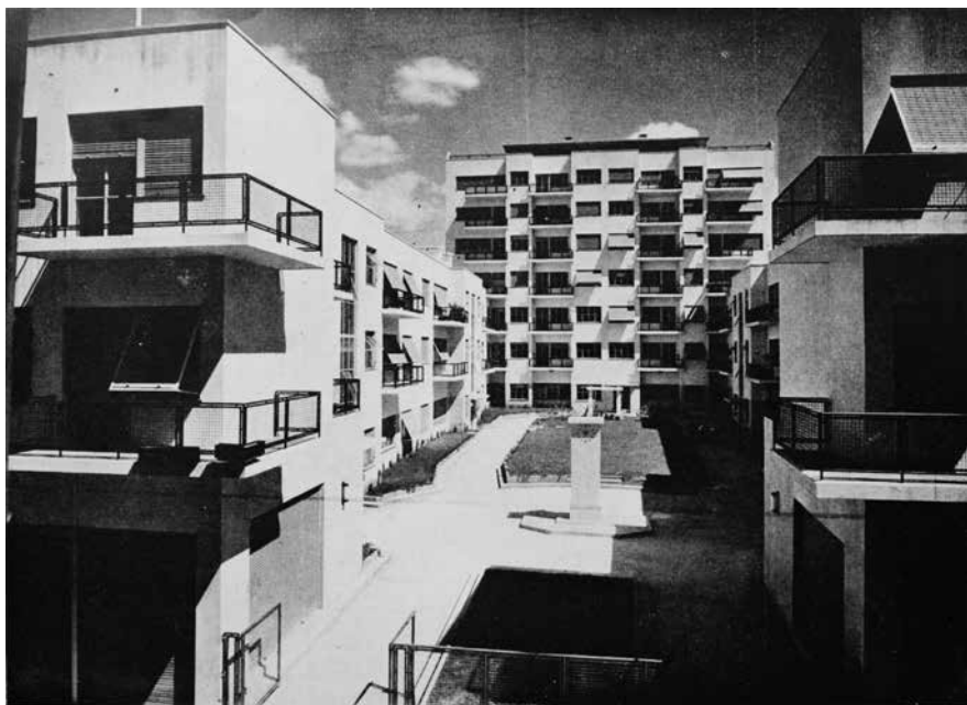
Foto de época de la Maison Solaire. Arq. León Dourge (1932). Revista Nuestra Arquitectura, Diciembre 1933 p. 149
